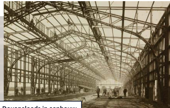
Douaneloods in aanbouw
