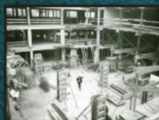
De gebouwen van de VDAB in volle opbouw © Willy Van Sprengel
